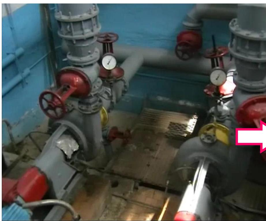
В насосной размещены циркуляционные насосы с турбоджетами (вихревыми генераторами), поддерживающими кавитацию расчетной интенсивности
